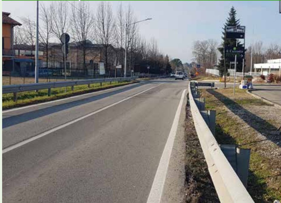
Dopo il ripristino con A. A. ANTIPUMPING HE/TVP da aprile 2014 a febbraio 2018 - 4 anni circa
