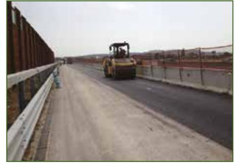
Occorre tener presente che nel caso di tratti di strada in curva si dovrà prevedere l'eventualità di tagliare i teli in pezzi più corti in modo tale da poter assecondare nel migliore modo possibile il raggio di curvatura in oggetto evitando la formazione di pieghe e garantendo al contempo le zone di sormonto minime previste.
