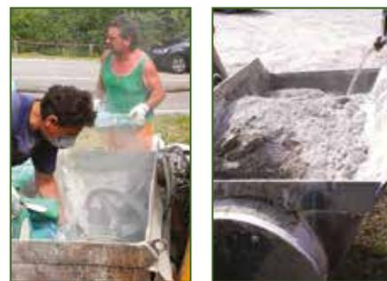
**3.** La malta viene versata nello scavo dalla stessa benna miscelatrice. Il materiale si compatta con facilità usando il vibratore.
