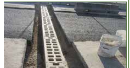
Il conglomerato viene rimosso in corrispondenza della trincea dove si alloggia il canale prefabbricato
