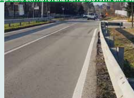
Febbraio 2018 - Sopralluogo - Dopo 4 anni circa dal ripristino con AUTOTENE ASFALTICO ANTIPUMPING
