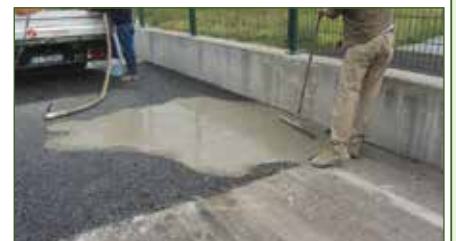
La saturazione delle porosità del conglomerato con una speciale malta cementizia ha lo scopo di aumentarne la portanza per sopportare il traffico pesante
