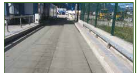
Stesura di AUTOTENE ASFALTICO ANTIPUMPING HE/TVP
