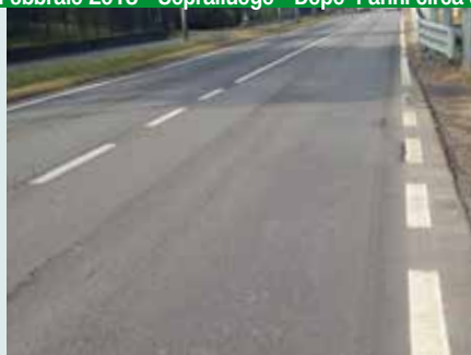
Febbraio 2018 - Sopralluogo - Dopo 4 anni circa dal ripristino con AUTOTENE ASFALTICO ANTIPUMPING
