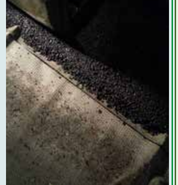
Agosto 2015 - Rifacimento con AUTOTENE ASFALTICO ANTIPUMPING
