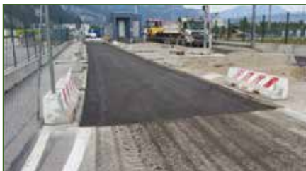
Dopo aver demolito il vecchio asfalto la pista viene ricoperta con uno strato di conglomerato riciclato a freddo
