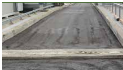
Le corsie sono attraversate da una trincea dove si alloggiano gli impianti
