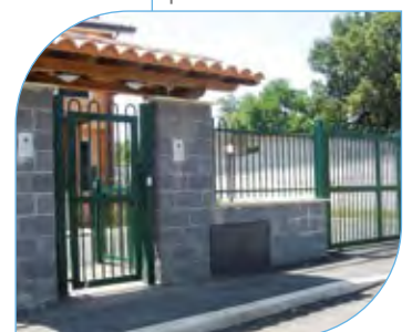
Recinzione e cancello pedonale e scorrevole
